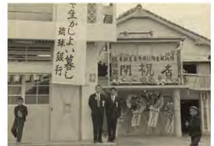
今帰仁預金取扱所新設(1960年12月)
