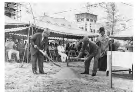
地鎮祭(1964年7月24日)
