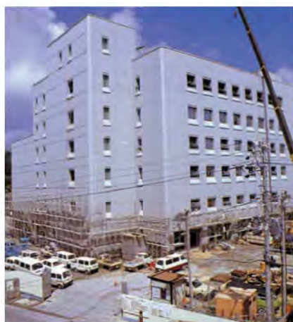
建築中の事務センタービル
